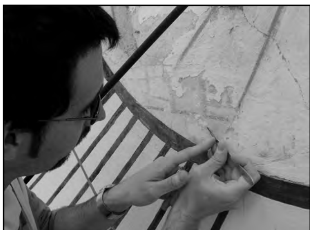
Diferentes fases del trabajo. Desencalado de los distintos estratos en la zona del sol y aplicación del gel decapante para eliminar la pintura plástica que cubría la moldura del reloj.
