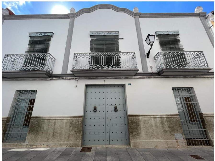
Façana actual de la casa d'Isidre Cucó (actualment de la família Albalat) al carrer Major o de Cucó, ara de Ladislao Soriano. Foto de M. Teresa Simón (setembre 2022)
