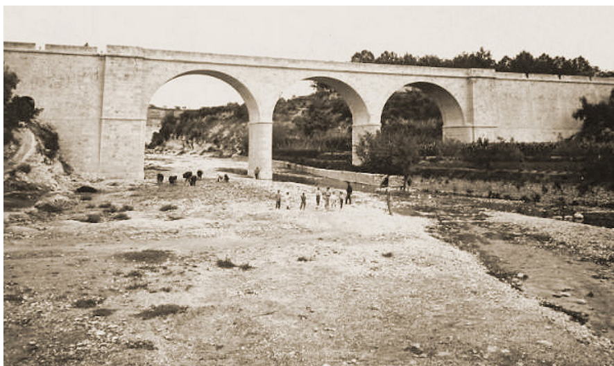
Pont Nou. AMO
