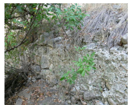
6: Aspecte del mur 1 (M1), des del sud-oest
