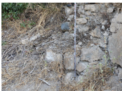
7: Aspecte del mur 2, en la base (M2-A)
