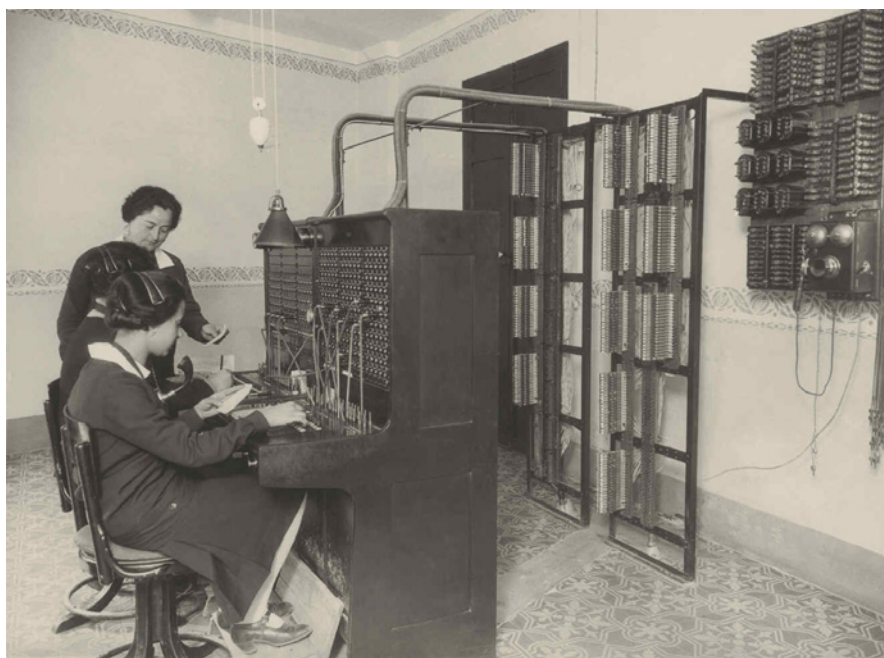
Central telefònica de Xàtiva, Carrer del Trovat, núm. 16. Autor: Marín, 1927
