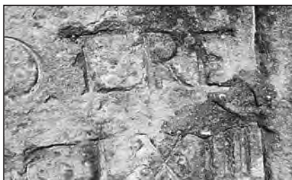
Figura 5. Detall de l'erosió superficial, la presència de taques d'oxalats i de concrecions originades per la presència de microorganismes biogènics
