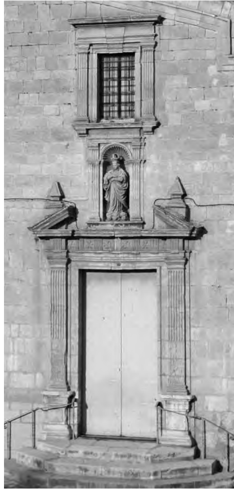
Porta de la capella de la Puríssima Concepció en l'any en què es commemora el 350 aniversari del començament de les obres de construcció.
