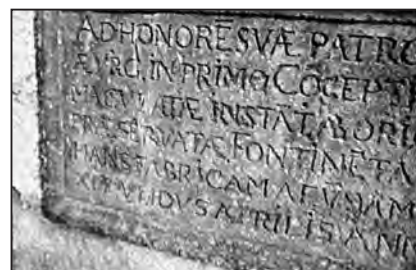
Figura 14. Detall després de l'aplicació de l'hidrofugant sobre la superfície de la cartel·la
