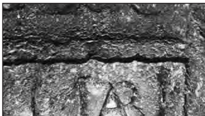
Figura 5. Detall de l'erosió superficial, la presència de taques d'oxalats i de concrecions originades per la presència de microorganismes biogènics
