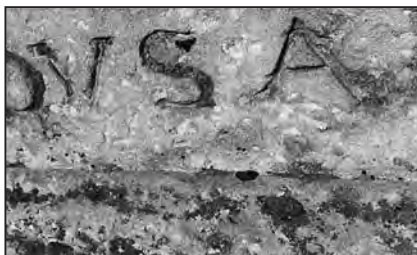
Figura 4. Detall de la descohesió del petri per esclament i per la presència de microorganismes biogènics
