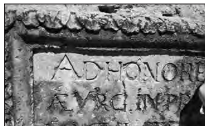
Figura 8. Eliminació en sec de la pol·lució depositada en superfície i remoció de la crosta biogènica altament pulverulenta
