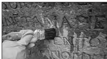
Figura 12. Detall del procés d'aplicació del consolidant BioEstel
