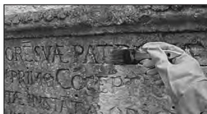
Figura 13. Detall de la fase d'aplicació de l'hidrofugant sobre la superfície de la cartel·la
